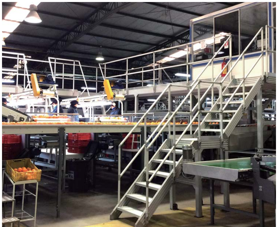
Bridge for Sorting Machine 分拣设备过线梯
