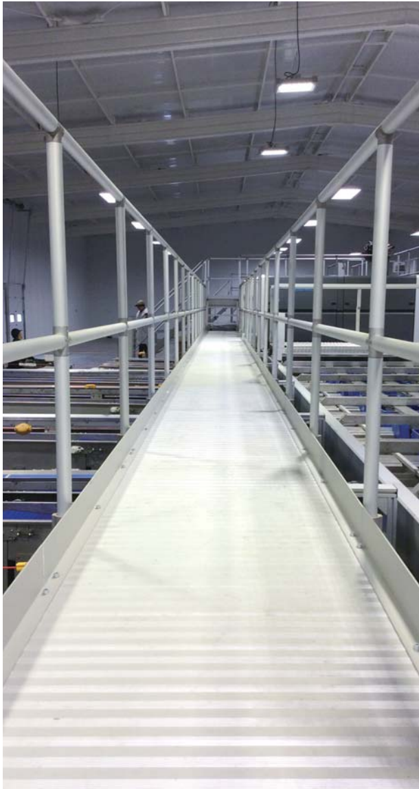
Bridge for Sorting Machine 分拣设备过线梯
